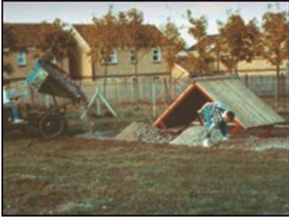
7. Fill stone foundation
